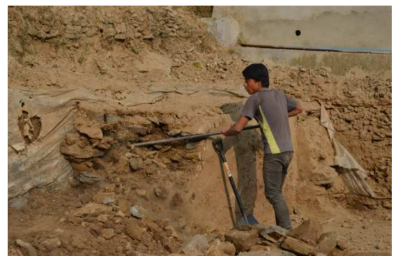
Agrandissement d'une plateforme à la barre à mine
