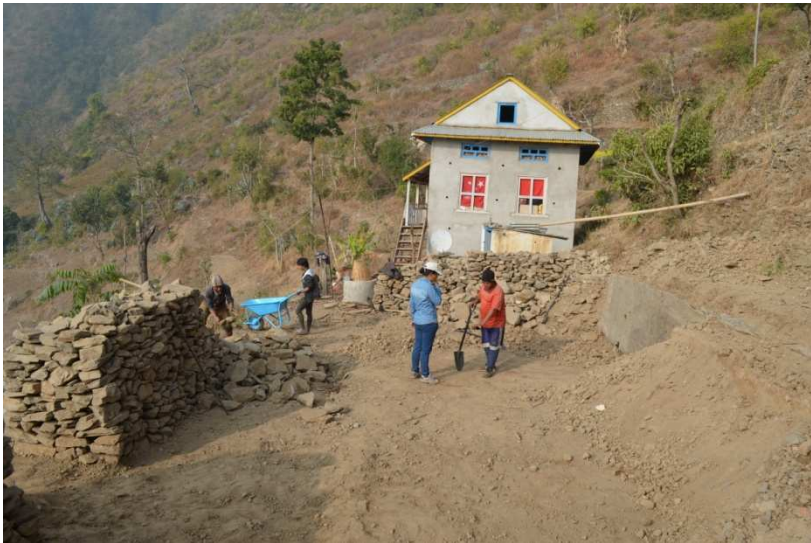
Nettoyage d'une plateforme
