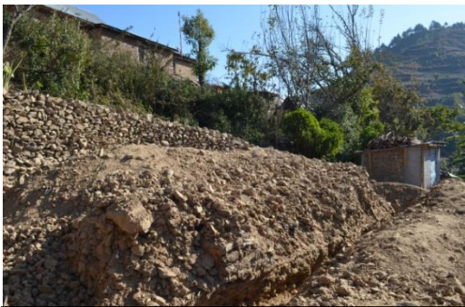
La maison 1 est entièrement démolie
